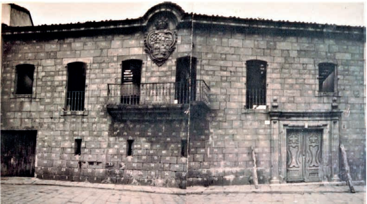
Pazo de la Merced o casa de los Bermúdez en Ferrol Vello. Fotografía de la fachada numerada poco antes de ser desmontada piedra a piedra, a. 1956. En la parte derecha de la imagen, el portalón de la entrada principal a la mansión. APCM, Ferrol.
